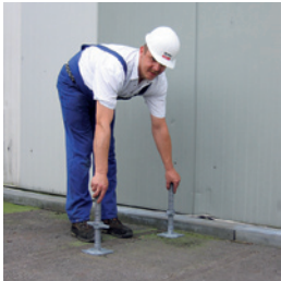
Gewindefußplatten aufstellen
