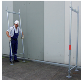
Vertikalrahmen aufstecken
